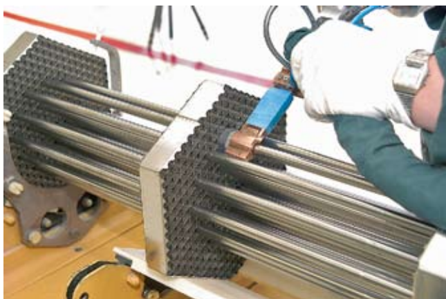
Каркас кассеты «ТВС-2» в процессе сварки
