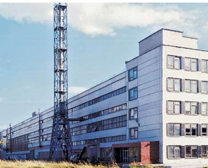
Химико-металлургический цех литейного производства
